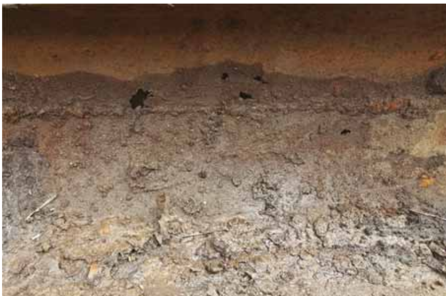
Рис. 11. Коррозионные повреждения трубопровода сетевой воды
