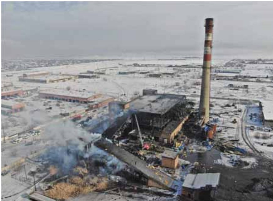
Рис. 16. Общий вид ТЭЦ после взрыва угольной пыли
