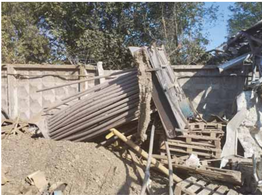
Рис. 18. Разрушенные котел и котельная ООО «Управляющая компания Орион»
