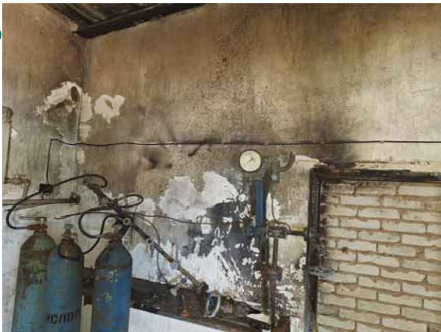
Рис. 15. Место происшествия. Поврежденная пожаром наполнительная рампа
