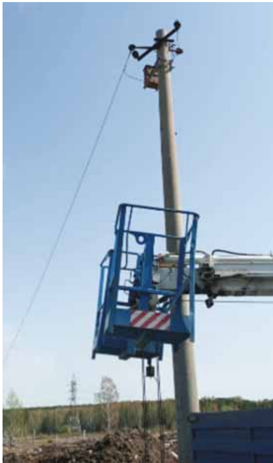
Рис. 8. Опора № 1, с установленным на ней повышающим трансформатором ОМП-6/0,23кВ и находящимся рядом многофункциональным краном-манипулятором МКМ-200
