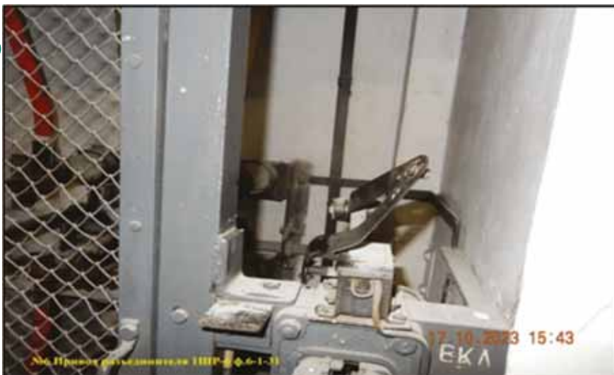
Рис. 6. Привод разъединителя 1ШР-6 ф.6-1-31
