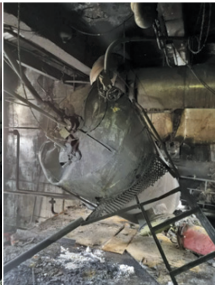
Рис. 4. Площадка второго этажа цеха акриловых эмульсий. Емкость поз. Е-1В для приема, хранения и выдачи бутилакрилата
