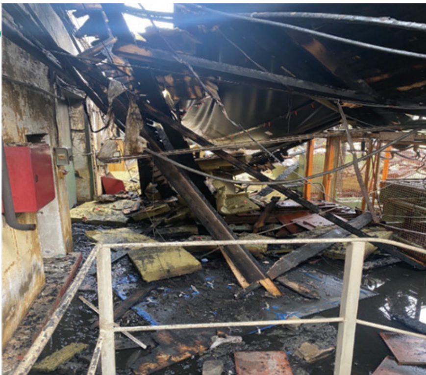
Рис. 15. Обрушенная кровля цеха (место происшествия)
