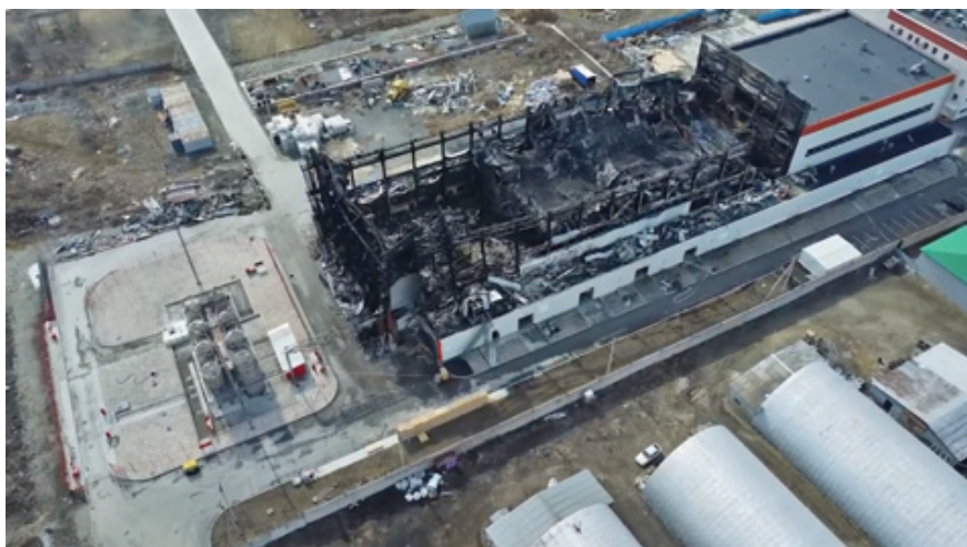
Рис. 1. Здание цеха по производству антикоррозионных лакокрасочных материалов
