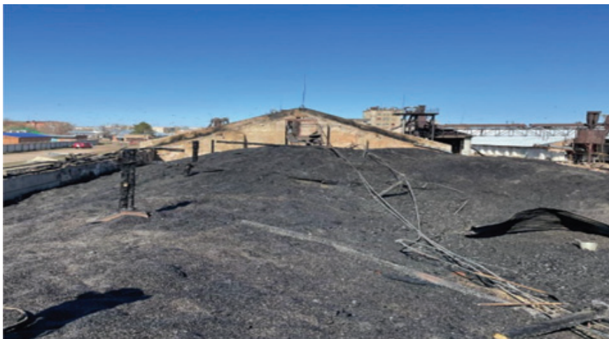
Рис. 12. Механизированный склад бестарного напольного хранения растительного сырья (место происшествия)
