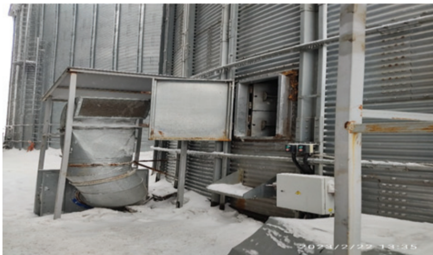
Рис. 11. Боковой люк металлического силоса, через который залез работник на насыпь
