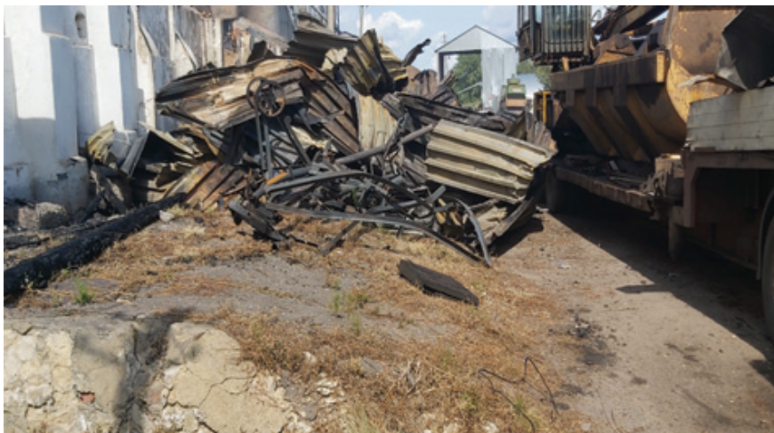
Рис. 22. Разрушенные технические устройства (ленточные конвейеры)
