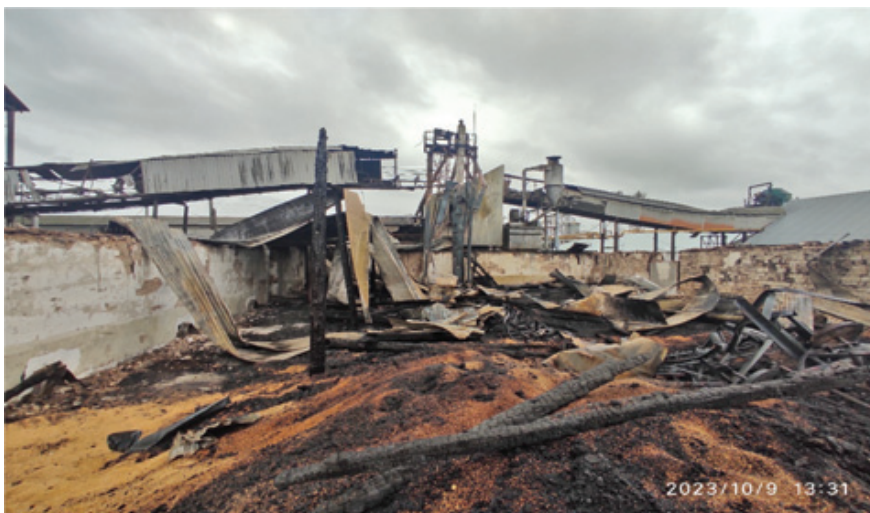
Рис. 29. Разрушенные галереи механизированных складов
