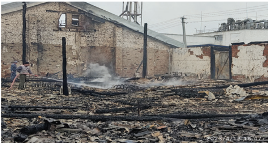
Рис. 13. Механизированный склад бесстарного напольного хранения зерна (место происшествия)
