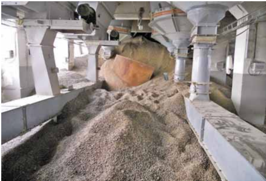
Рис. 12. Место аварии и несчастного случая, общий вид (силосный склад сырья, подсилосный этаж)
