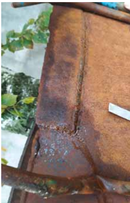
Рис. 13. Приваренная накладка к верхней части обечайки
