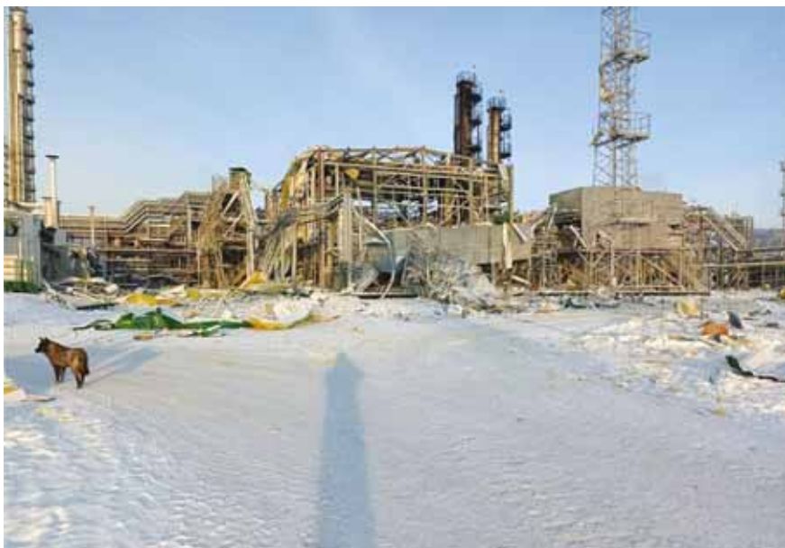
Рис. 45. Блок стабилизации газового конденсата (БСК) с прилегающей к нему технологической эстакадой после пожара
