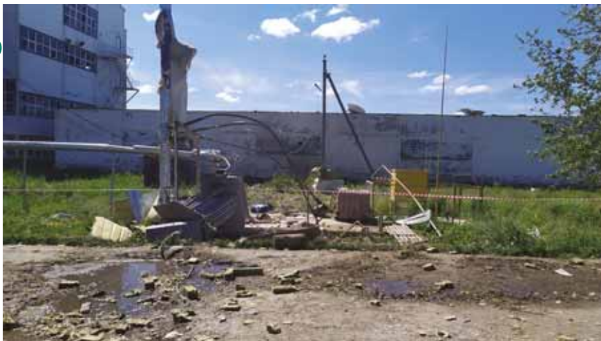
Рис. 12. Вид котла после разрушения
