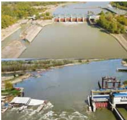
Рис. 42. Общий вид гидроузла до и после разрушения
