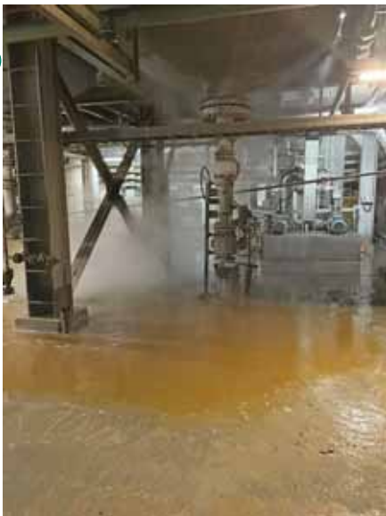
Рис. 14. Место происшествия. Дренажный штуцер СВД № 1
