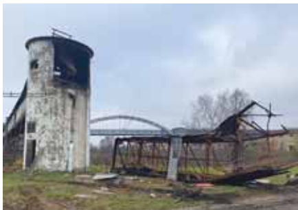
Рис. 9. Место пожара. Опорная башня конвейеров
