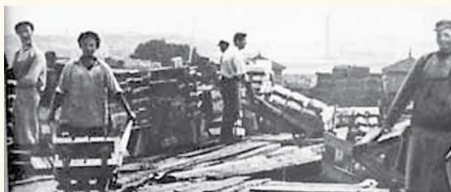
Строительство 1-го Государственного подшипникового завода (ГПЗ-1), 1929 г.
